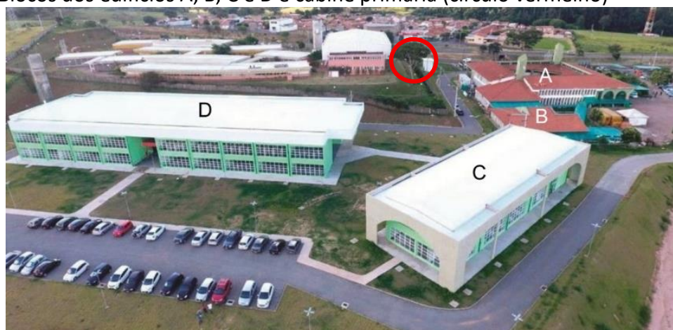
FIGURA 1 – Blocos dos edifícios A, B, C e D e cabine primária (círculo vermelho)
